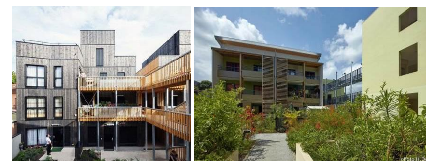
Exemples de bâtiments avec coursive extérieure
