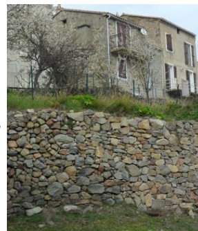
Exemple de murs de soutènement
