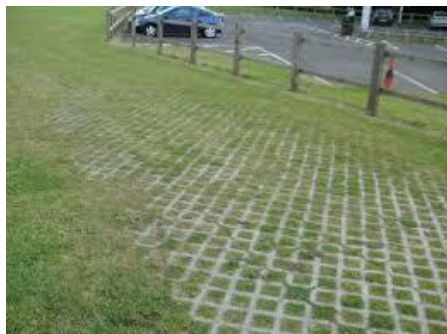
Exemple de sol drainant stabilisé >
