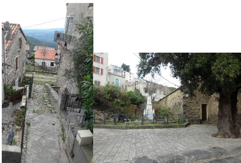
Les travaux sur le domaine public
