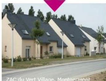
ZAC du Vert Village. Montgermont
