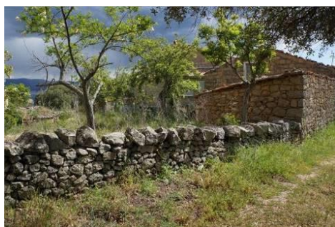
Conservation d'un muret ancien
