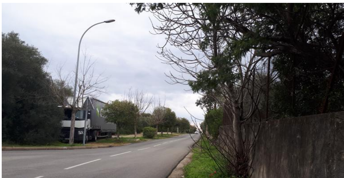
La RD qui longe le futur centre culturel (ancienne usine abandonnée actuellement)
