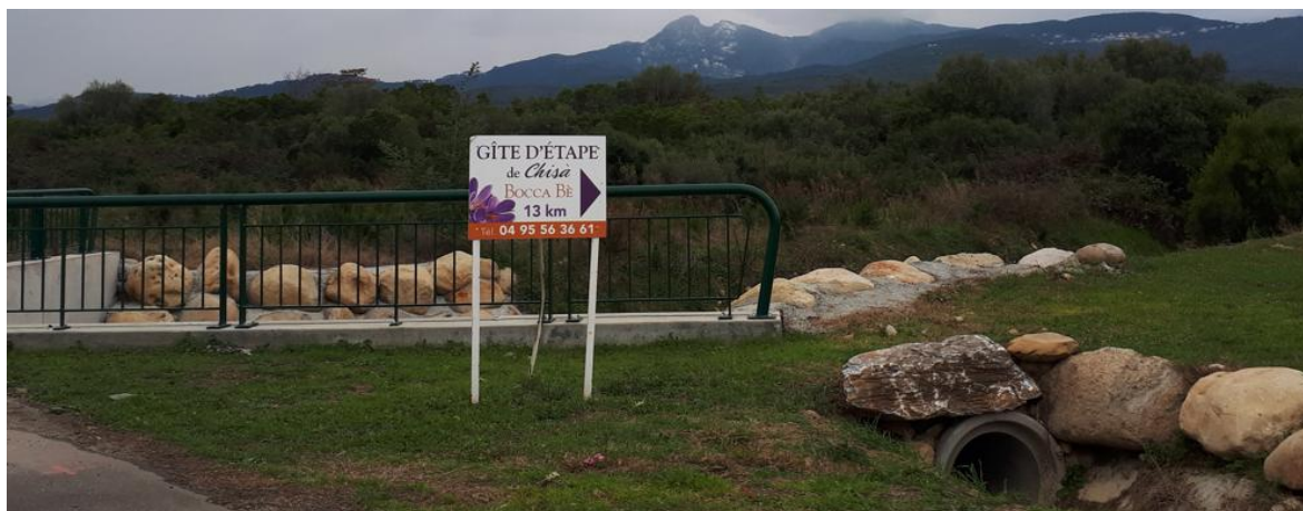
Exemple de travaux réalisés
