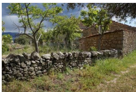
Conservation d'un muret ancien
