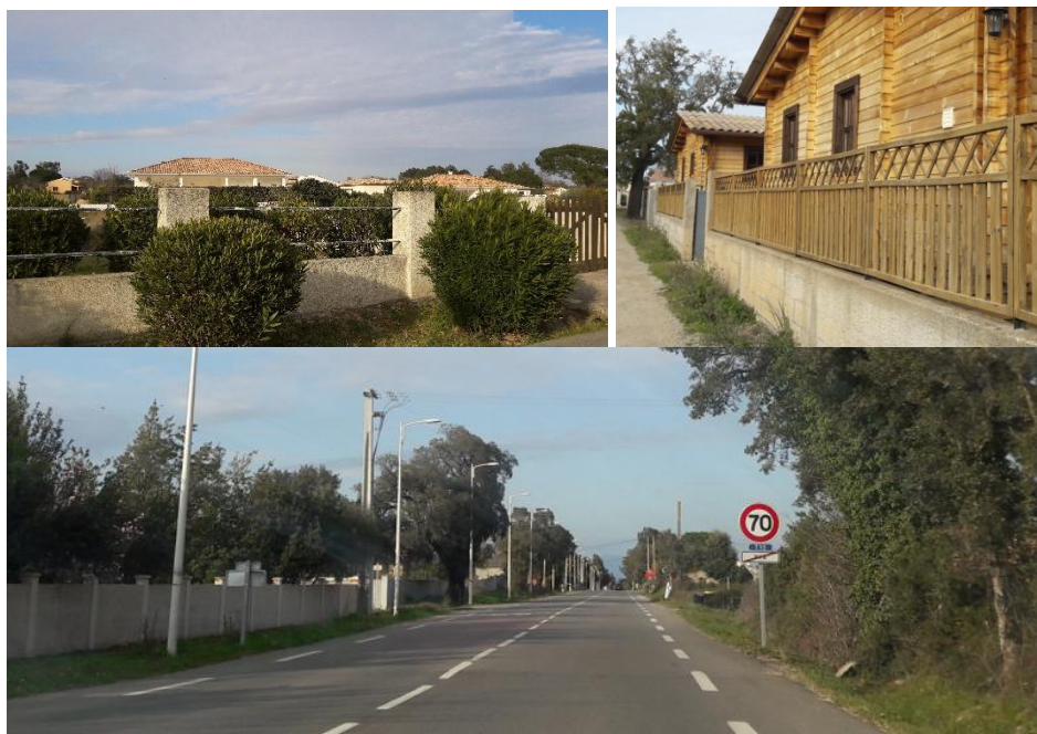
Exemple de cloisonnement des milieux par les clôtures hors village et agglomération
