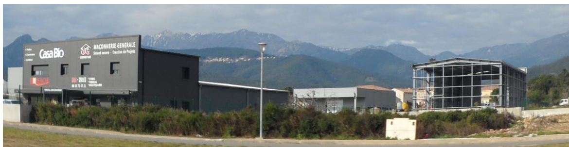
Etablissements économiques existants et en cours de constructions (2024) au nord de la zone
