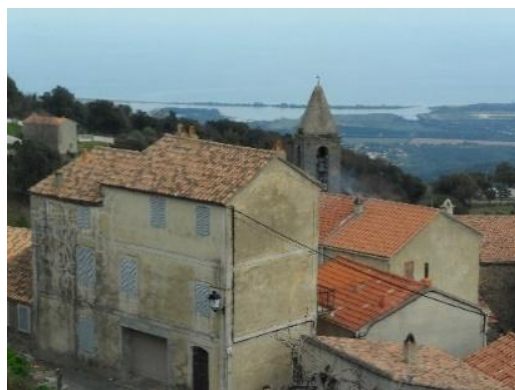
Vue plongeante sur les toitures
