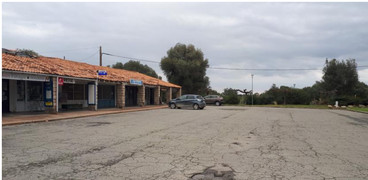
Quelques commerces fermés dans un bâtiment au centre de Travo
